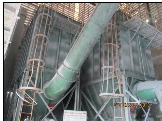
ภาพที่ 2.29 การติดตั้งเครื่องดักฝุ่นแบบถุงกรอง บริเวณเครื่องบดย่อยหิน
